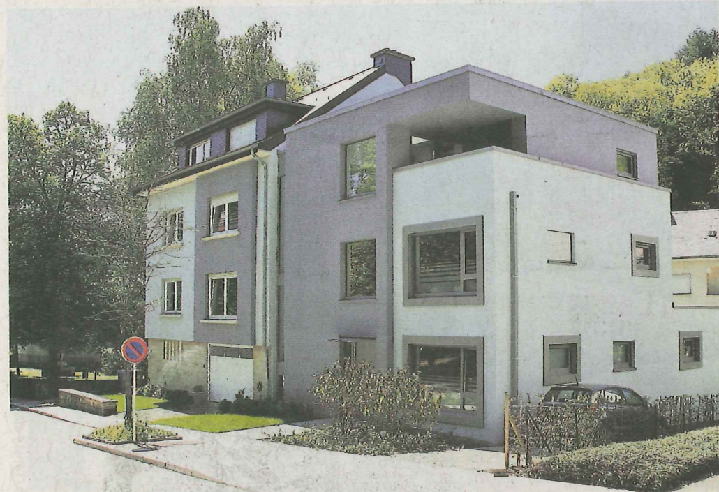
Das Haus wurde von Grund auf saniert
